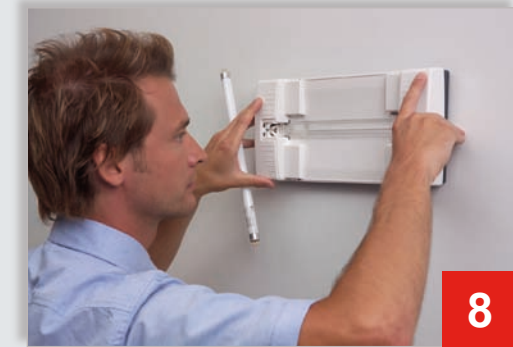
Armatuur in elkaar zetten en sluiten
