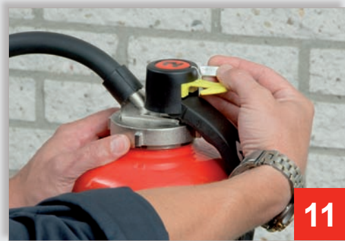
Blustoestel wordt verzegeld met indicator en zegel
