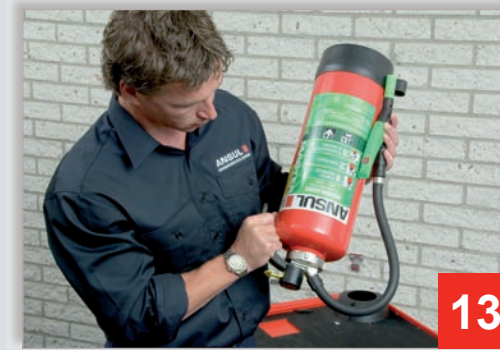
Blustoestel controleren op lekkage
