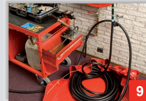
9 De perszak voorkomt waterschade
