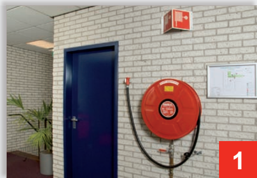
1 Is de haspel vrij toegankelijk, herkenbaar gemarkeerd en zijn de bedieningsinstructies duidelijk leesbaar?
