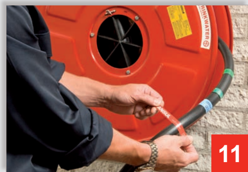
11 Begin van de slang wordt voorzien van een zegel
