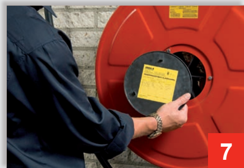
7 Noteren van de gemeten waarden van de test
