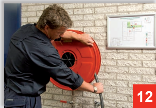
12 Slang wordt vakkundig gemonteerd en opgerold, zodat deze naar alle kanten goed afrolbaar is
