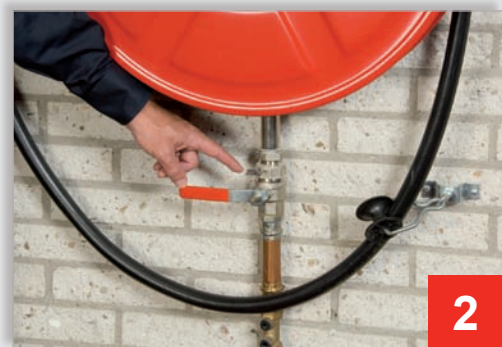
2 Verzegeling controleren
