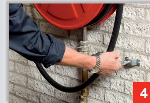
4 Beoordelen werking slanggeleider
