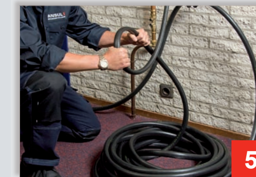
5 Slang volledig afrollen en controleren op beschadigingen
